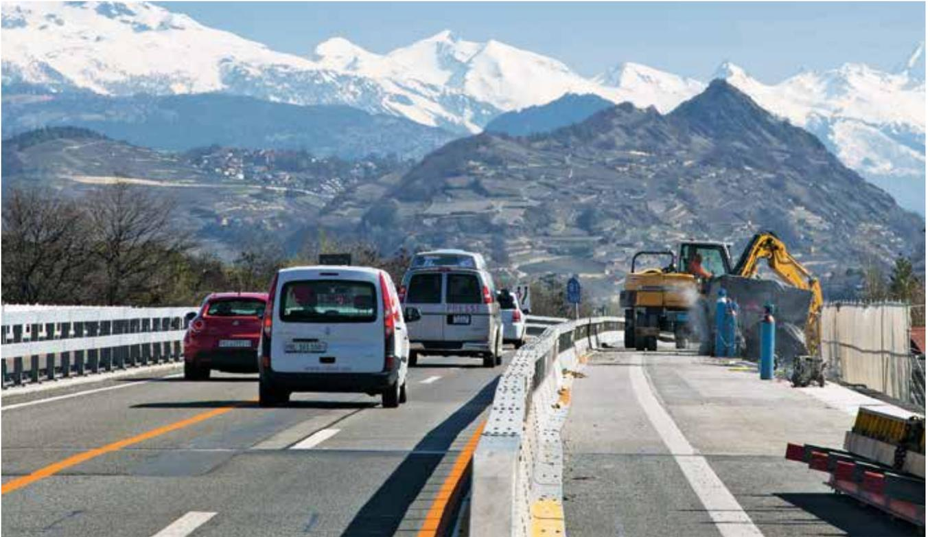
Links Verkehr, rechts Baustelle: Bei der Sanierung dieser Brücke auf der A9 im Wallis wird der Baustellenbereich mit mobilen Leitplanken aus Metall abgetrennt und gesichert.
