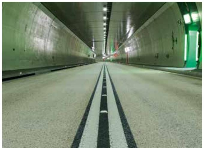
*Im Tunnel von Lungern wurden vier Streckenabschnitte bezüglich der Farben der Decke und des Asphalts unterschiedlich gestaltet. Ziel der Studie war, die Auswirkung der Helligkeit auf den Stromverbrauch im Tunnel festzustellen.*
