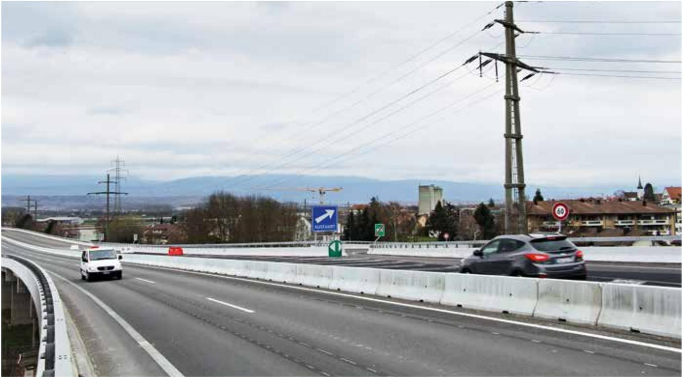
Auf dem Viadukt von Kerzers sind hinereinander sechs verschiedene Asphalttypen eingebaut. Ziel des mehrjährigen Tests: Erkenntnisse über Lärmverhalten und Korrosionsschutz gewinnen.
